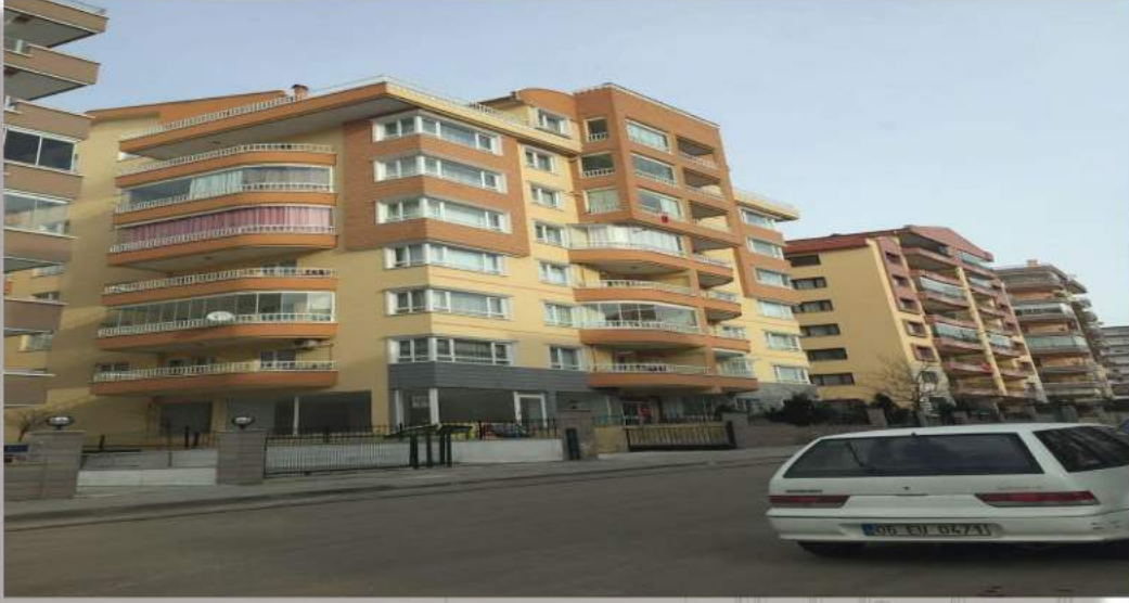
Elif Apartmanı (Akdere)
