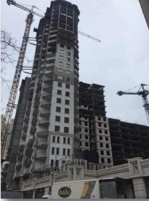
Ukrayna Odessa Gefest (Milos-1) Duvar İmalatı 2020
